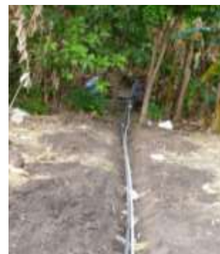
Tubería en una Zanja
